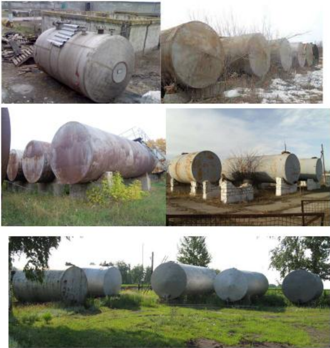
Рис. 1.3 – Фрагменти незадовільного технічного стану нафтоскладів сільгосппідприємств.
