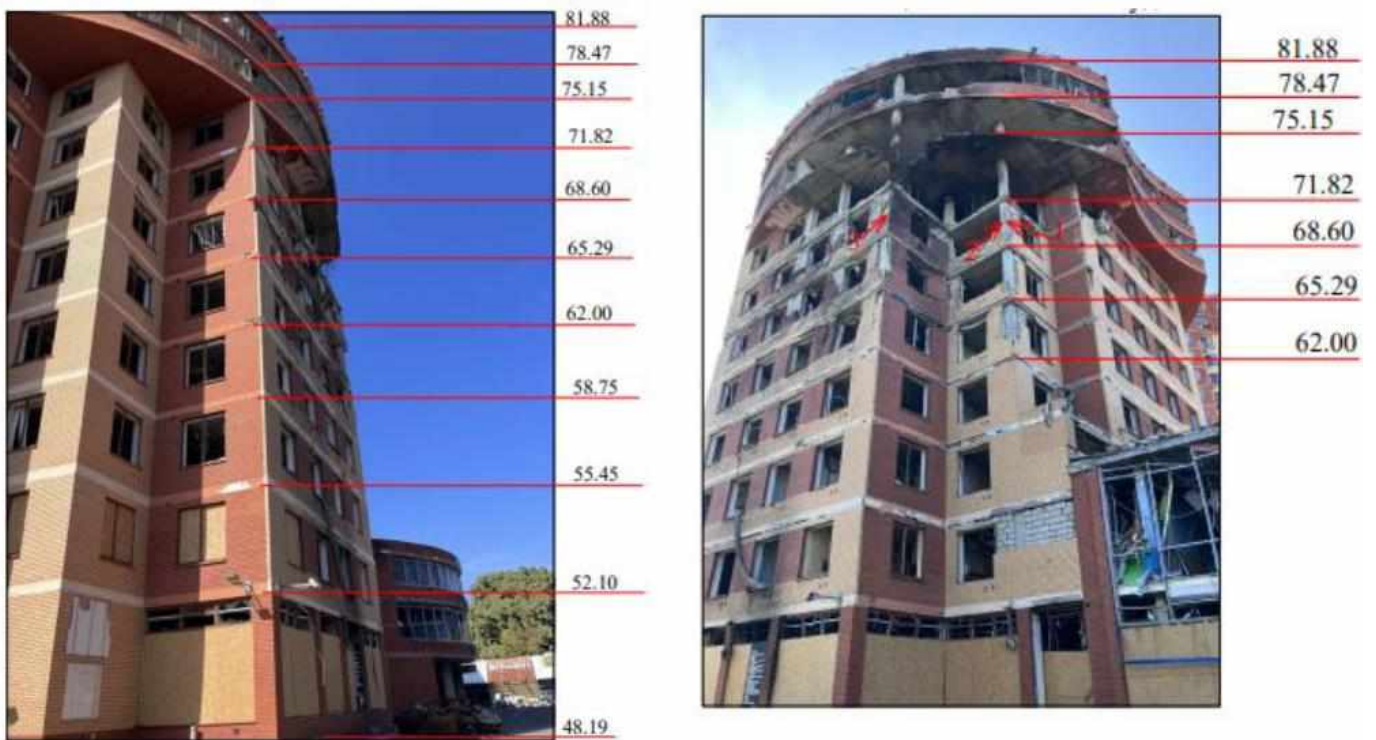
Рис. 3 Схема визначення крену з прив'язкою по висоті
