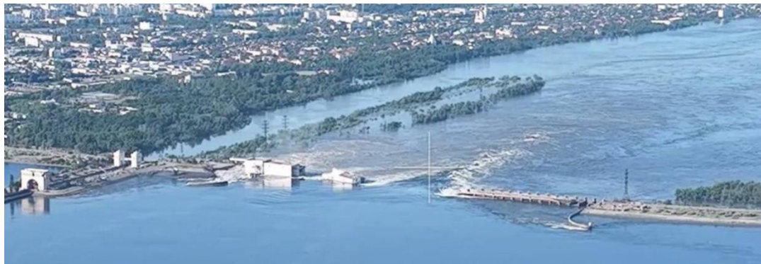
Рис. 1.2. Вигляд зруйнованої греблі Каховської ГЕС станом на ранок 6.06.23 р.
