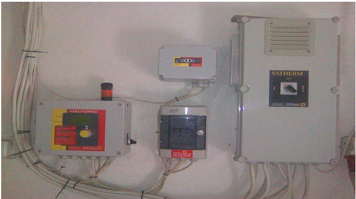
Рис. 12. Автоматичне регулювання мікроклімату в цеху опоросу
