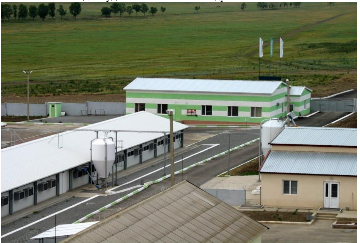
Забудова території племінного заводу: санпропускник, адміністративний комплекс, кормоцех, цех дорощування, племінний зал.
