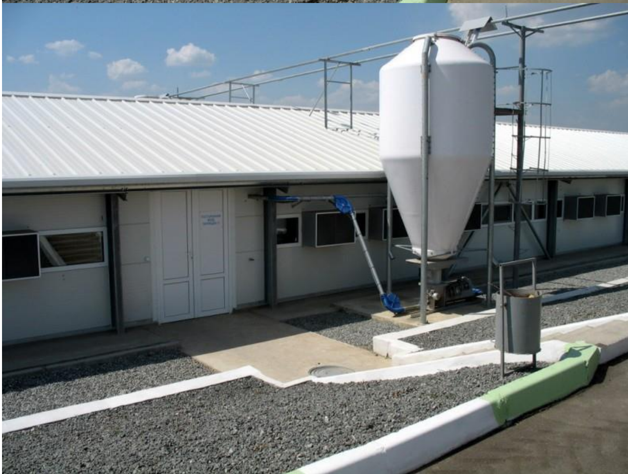
Стан території, приміщень, обладнання.
